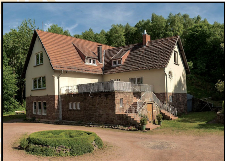
Escuela Neijing Sulzbach
